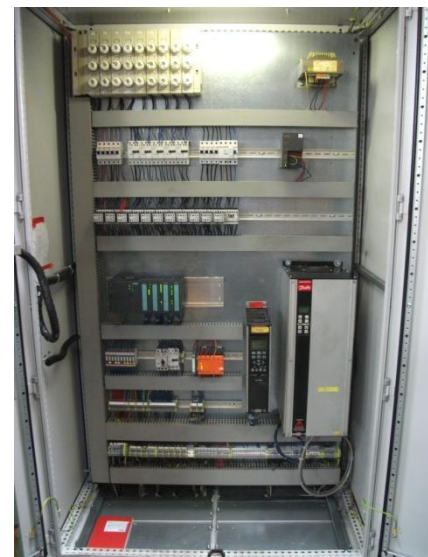
Abb,120: Neue Zustand
