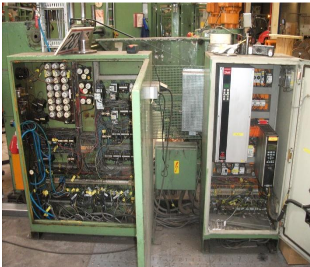
Abb,129: Alte Zustand
